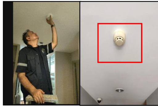
ภาพที่ 29 Smoke Detector
