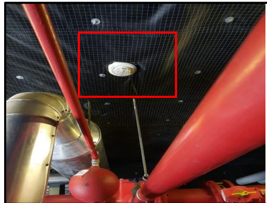
ภาพที่ 32 Heat Detector
